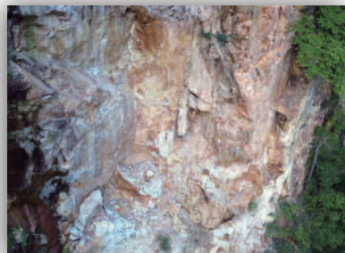
崩落部をドローンにて撮影 ②
