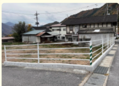
利根町追貝地区通学路安全対策
