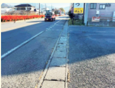
国道120号 側溝の蓋破損補修工事
