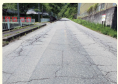
利根町南郷地区付近のセンターライン
