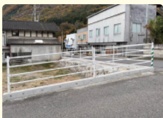
空き家解体により大きな段差ができてしまったため安全対策が施工された
